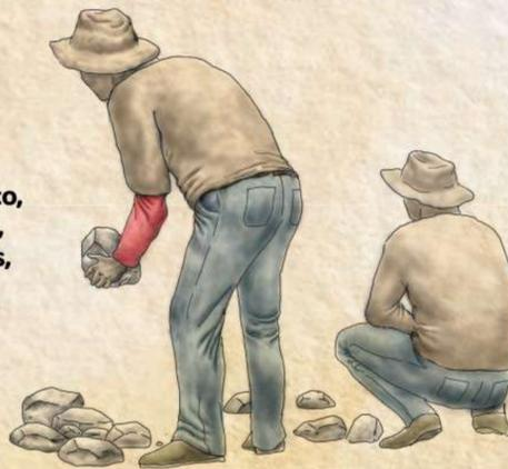
3. Se escogen las piedras y se limpian con una escobilla o con agua si es necesario. Luego se colocan ordenadamente en la zona elegida para realizar el circuito. Para alinearlas, se utiliza un cordel y estacas.
