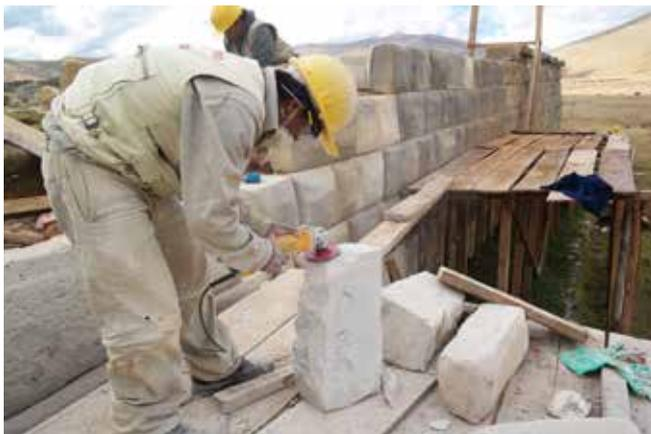
Figura 5. Labor de pulido de piedra caliza para la sustitución.
