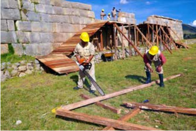
Figura 4. *Habilitación de andamios para las labores de desmontaje y rearmado de muro.*
