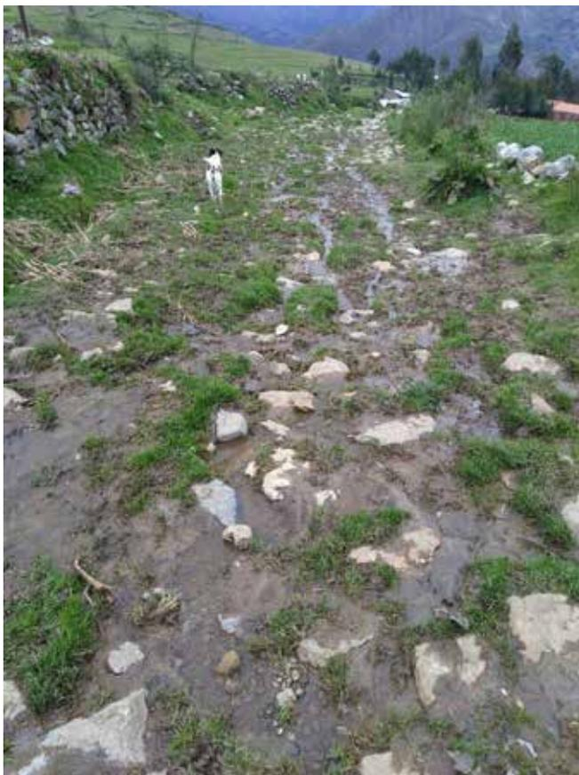
Figura 8. Vista panorámica de la calzada del camino, los aniegos y escorrentías de agua eran una afectación constante.
