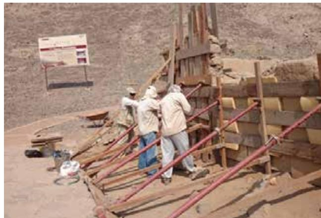
Figura 5. Fotografía de apuntalamiento de Muro MB-38.
