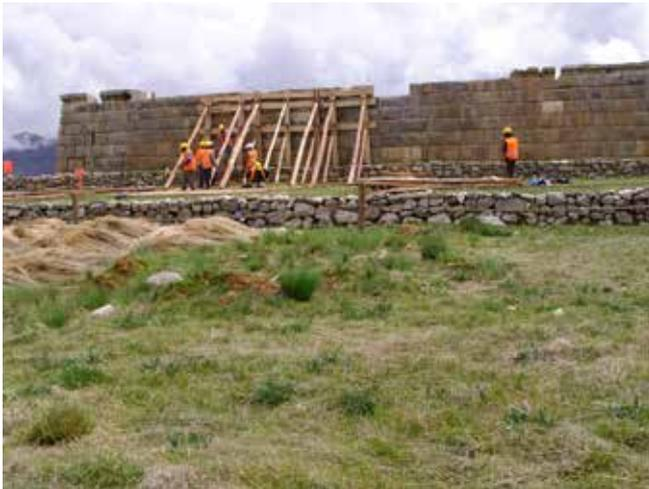
Figura 1. Labores de apuntalamiento preventivo del muro oeste del Ushnu, realizado en el año 2009.
