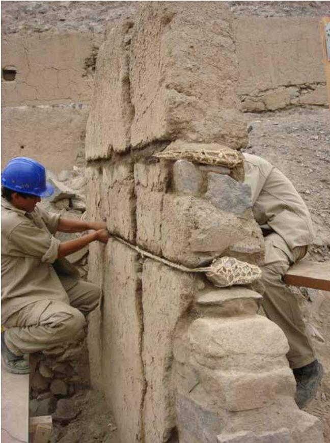
Figura 6. Fotografía de refuerzos con zunchos en Muro ME-56.
