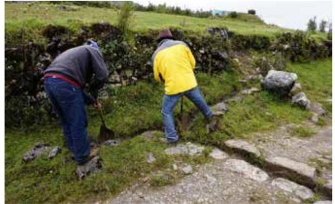
Figura 2. Limpieza de drenes y descolmatación de canales para evitar los desbordes e inundaciones.
