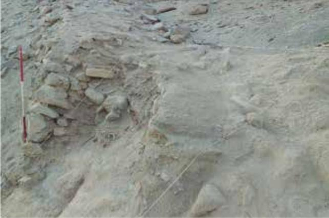
Figura 31. Muro de contención del camino. Obsérvese el relleno de fibra vegetal. Cerro Pampa Afuera.
